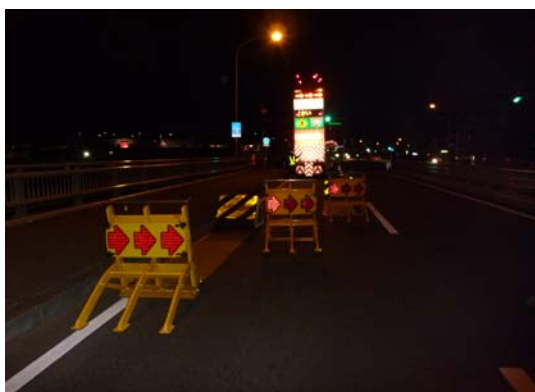
高さ6.65mの大型規制看板
